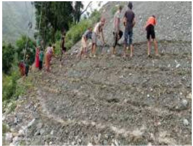
पहिरो तथा सडकपाखोमा लाईन मिलाएर नेपिएर घाँसको कटिड लगाउने तरिका
